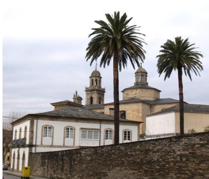
Casa de Oya. (Lourenzá, Lugo) -22 e 21 m de altura.
