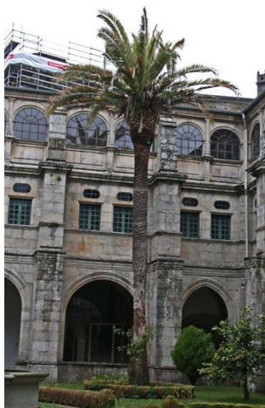
Mosteiro de Samos. (Samos, Lugo) -13,50 m de altura
